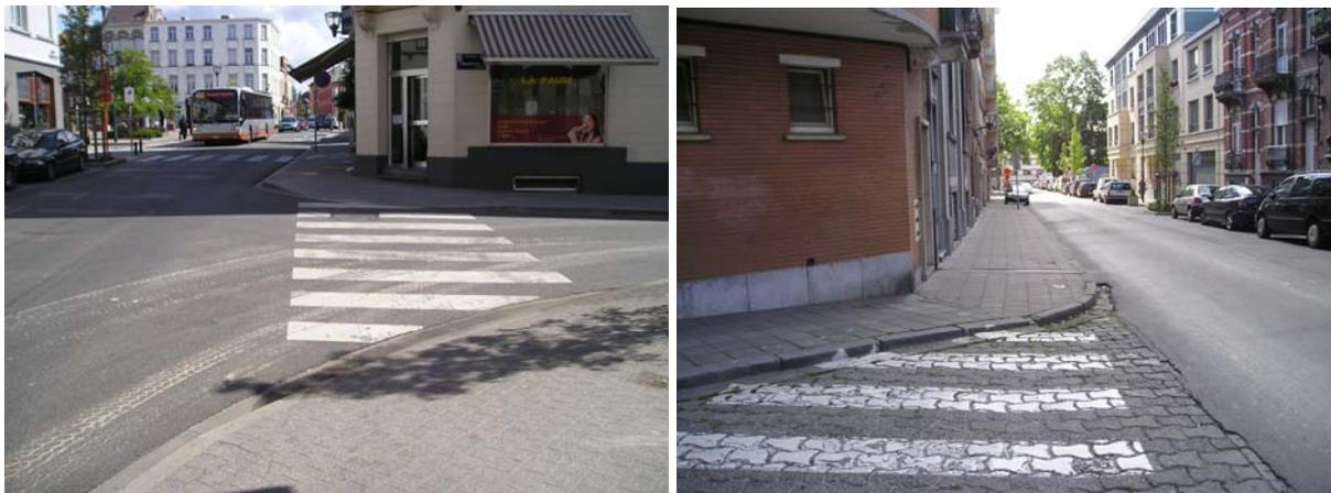
*Rue de l'Eglise Sainte-Anne (à gauche, carrefour avec la rue Delcoigne), une traversée piétonne abaissée et adaptée pour les PMR ; Mais il subsiste aussi des traversées inadaptées aux PMR (cf. à droite, carrefour de la rue Delcoigne et la rue de la Sécurité).*
