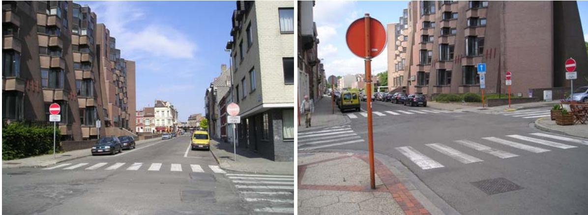
*Rue Vande Sande : des carrefours à doter d'oreilles de trottoirs et dont les traversées piétonnes doivent être adaptées aux PMR.*
